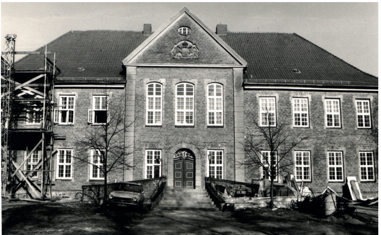
Abb. 5: Das Herrenhaus im Umbau, 1970er-Jahre. (Kreismuseum Herzogtum Lauenburg)
