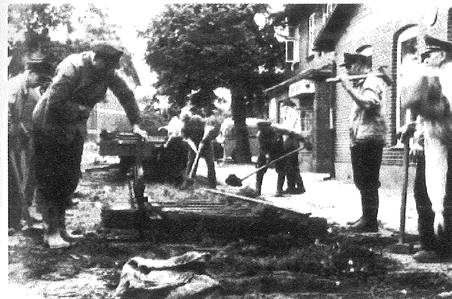
Die Abbruchkolonne hat Vogelsang-Grünholz erreicht. Rechts das Bahnhofsgebäude.
