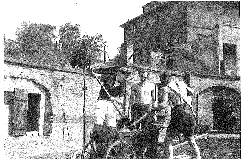
Abb. 2: Aufräumarbeiten auf dem Alten Universitätsgelände, ca. 1945/46.
