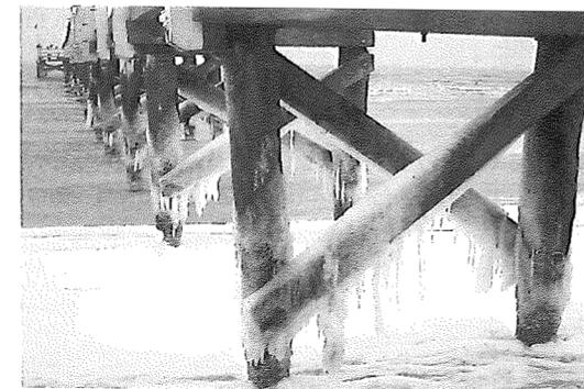
Abb. 1: Anders als bei einer Mole beispielsweise stehen Seebrücken auf Pfählen im Wasser – wie hier die alte Kellenhusener Brücke.
