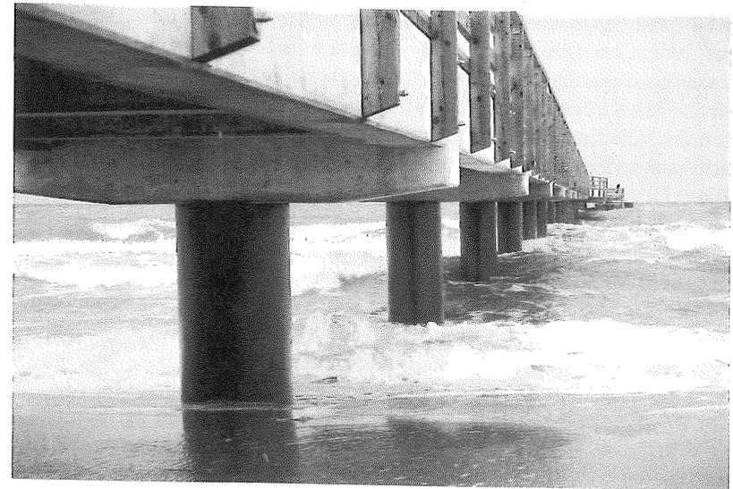
Abb. 8: Die 260 Meter lange Schönberger Seebrücke steht auf 33 Stahlbetonpfählen.
