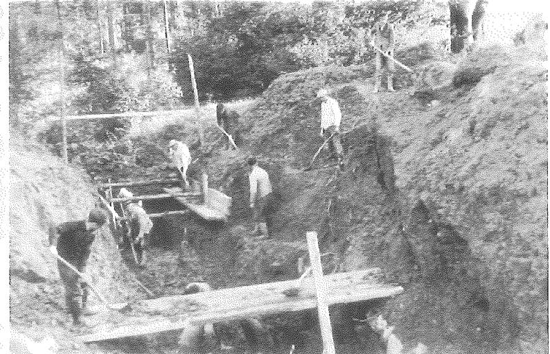
Abb. 1: Baugruben, Bachbettverlegungen und -durchlässe wurden in aufwändiger Handarbeit fertig gestellt.
